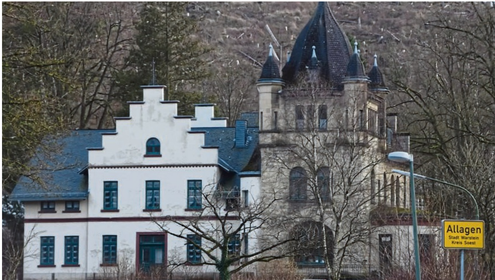
Im Spänebunker des „Hauses Dassel“ brannte es am dritten Adventswochenende. Seitdem kann das Gebäude nicht genutzt werden. FOTO: ALEXANDER LANGE
