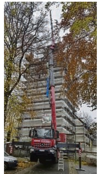
Die Arbeiten an der Alten Kirche laufen, das Turmkreuz ist zurück. FOTO: SCHREWE
