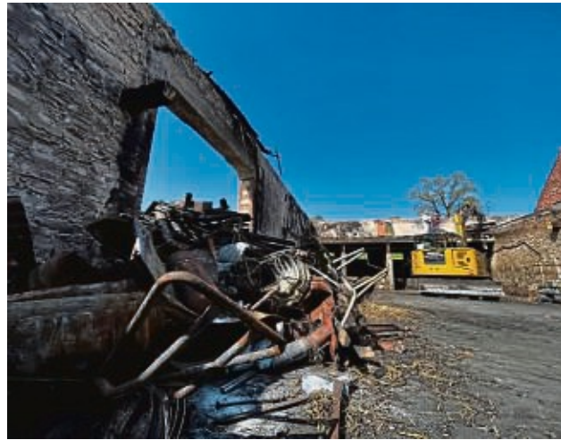
Aktuell wird der Brandschutt der Scheune entsorgt.
