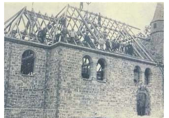
Als der Dachstuhl fertig war, wurde Richtfest gefeiert.
