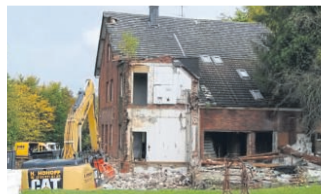
Hotel Postillion weicht dem neuen Bauprojekt.
